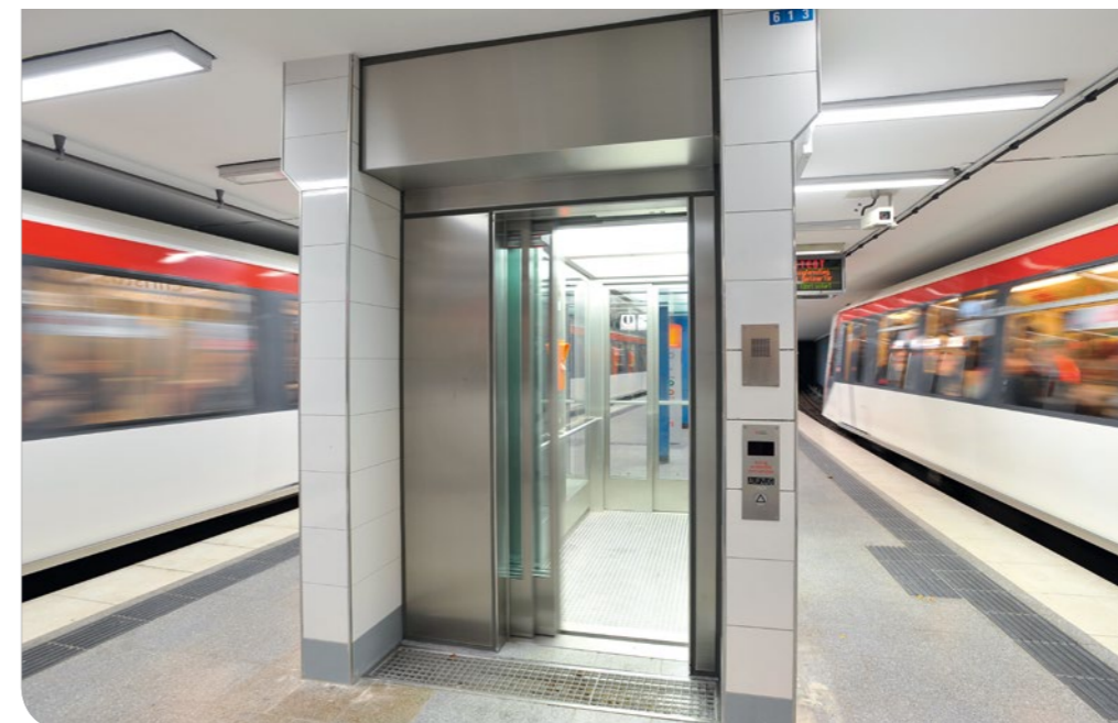
Der jahrelang von den Seniorenbeiräten geforderte Einbau von Aufzügen in Schnellbahnstationen schreitet voran. Ende März 2019 wurde die 66. U-Bahn-Haltestelle barrierefrei
